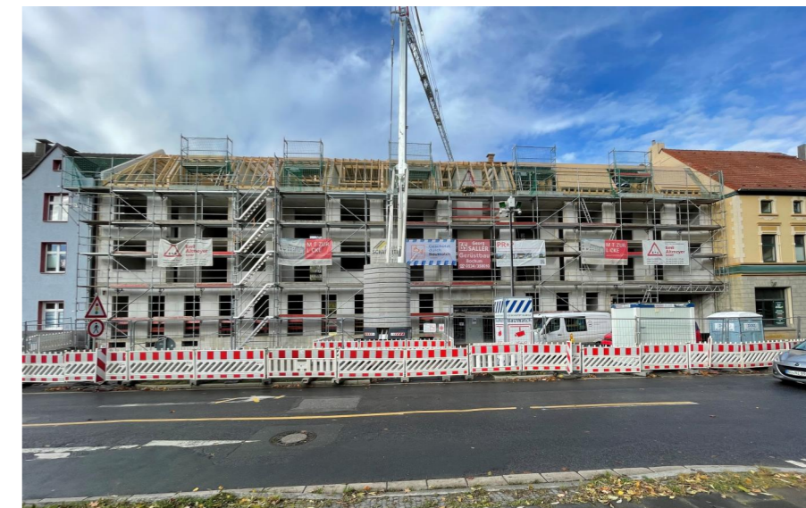
Errichtung Rohbau Straßenansicht
